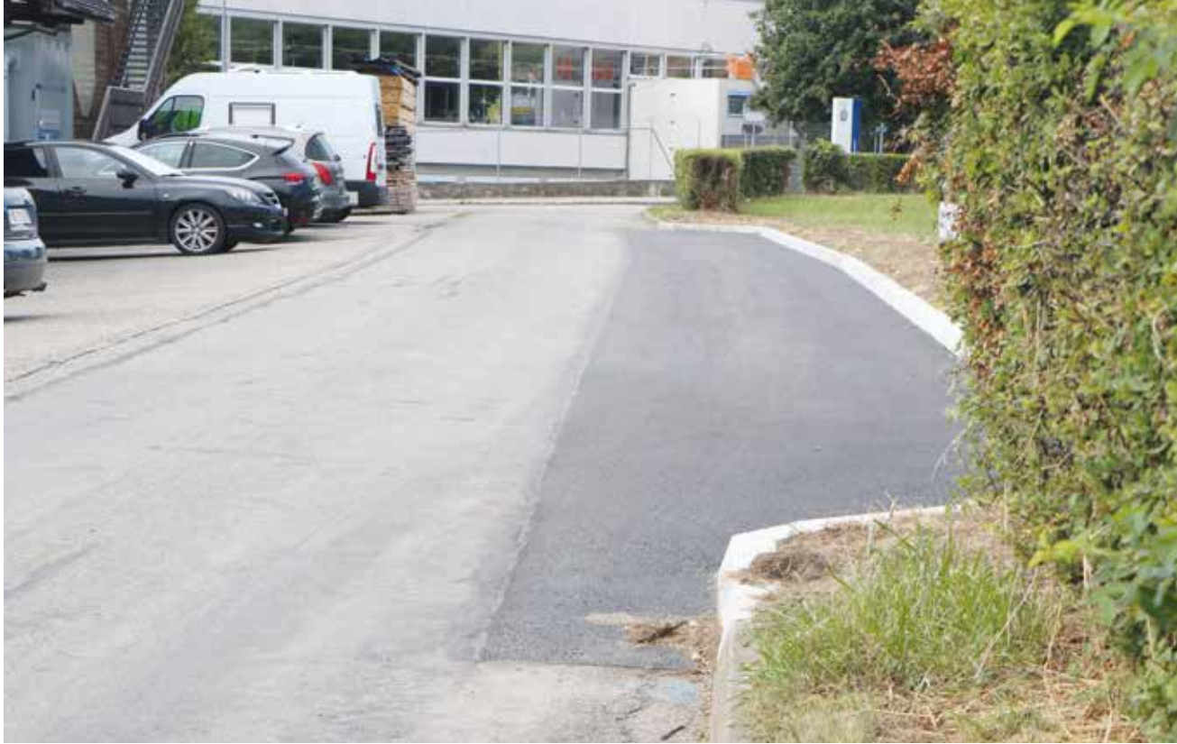
Un simple élargissement à la rue de l'Industrie pour faciliter le croisement des camions. (Photo pif).
